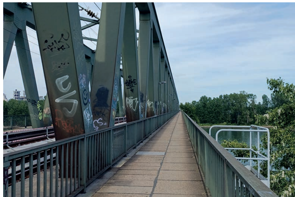
Der Fuß- und Radweg über die Kaiserbrücke wurde im September 2026 saniert.
