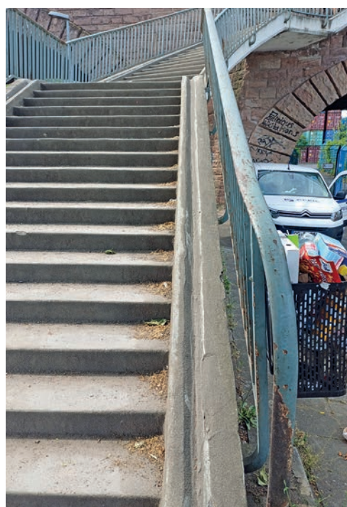
Die Schieberille beim derzeitigen Treppenaufgang zur Kaiserbrücke
